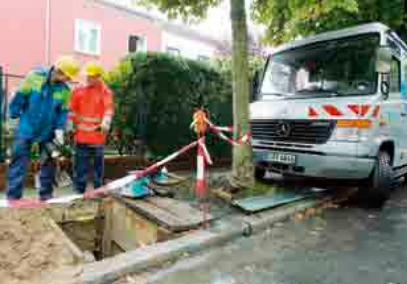
Bau eines Hausanschlusses an die Wasserversorgung
