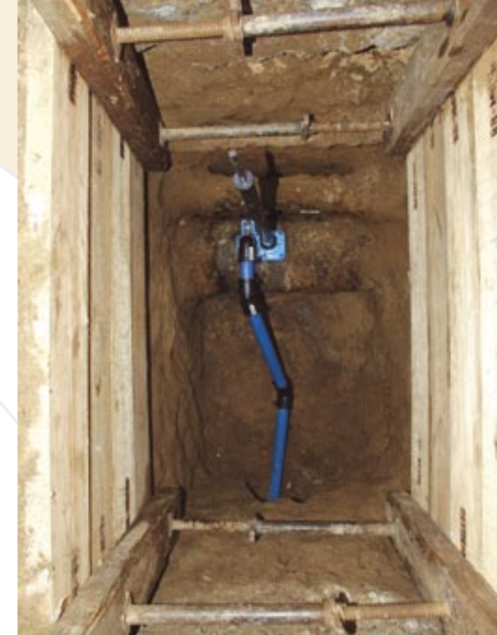
Anschluss an eine Trinkwasserversorgungsleitung
