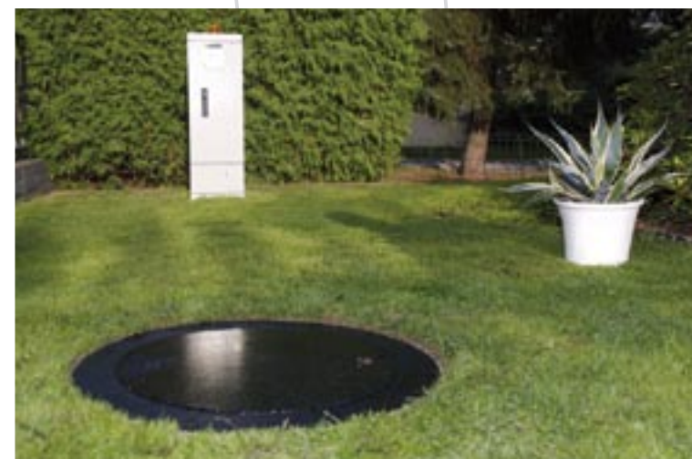
Druckentwässerungsanlage, Einbaubeispiel, im Hintergrund der Steuerschrank
