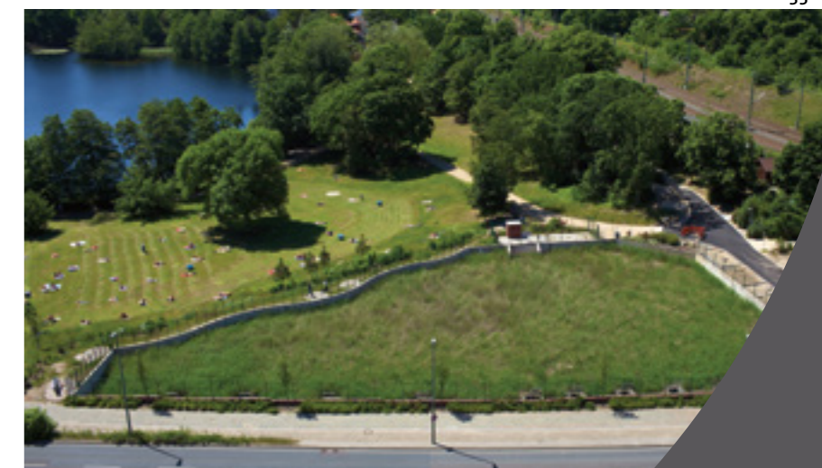
Retentionsbodenfilter reinigen verschmutztes Regenwasser von Straßen vor der Einleitung in die Gewässer.
